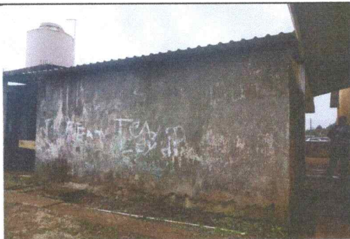
Foto 5: Se observa la presencia de humedad en el modulo de baños para varones
